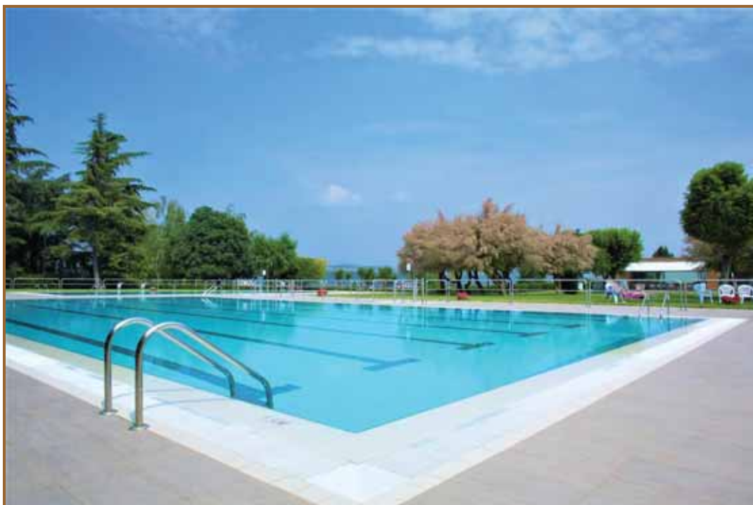
Il rinnovamento dell'area delle piscine, 2013
